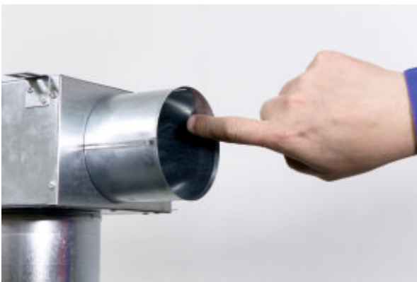
3) Vnitřní povrch vyústku namažeme kluzným přípravkem*.
